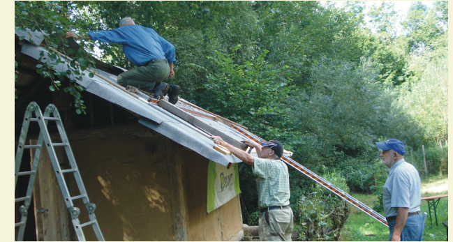
Fleißige Helfer im Einsatz bei der Dacherneuerung unseres Steinzeithauses. Bildautorin: Irene Zepf
